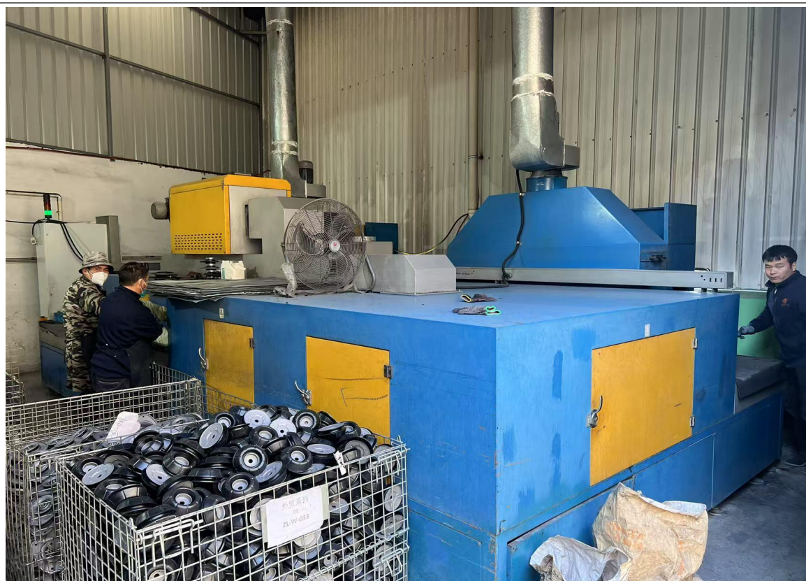
1#喷漆流水线（2 个干式喷台）
